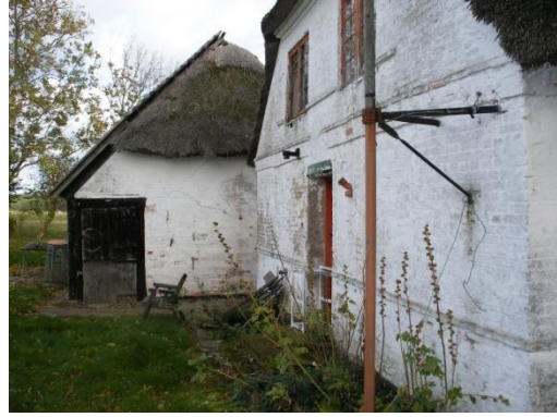
Vestlængens gavl (med sorte dør)
